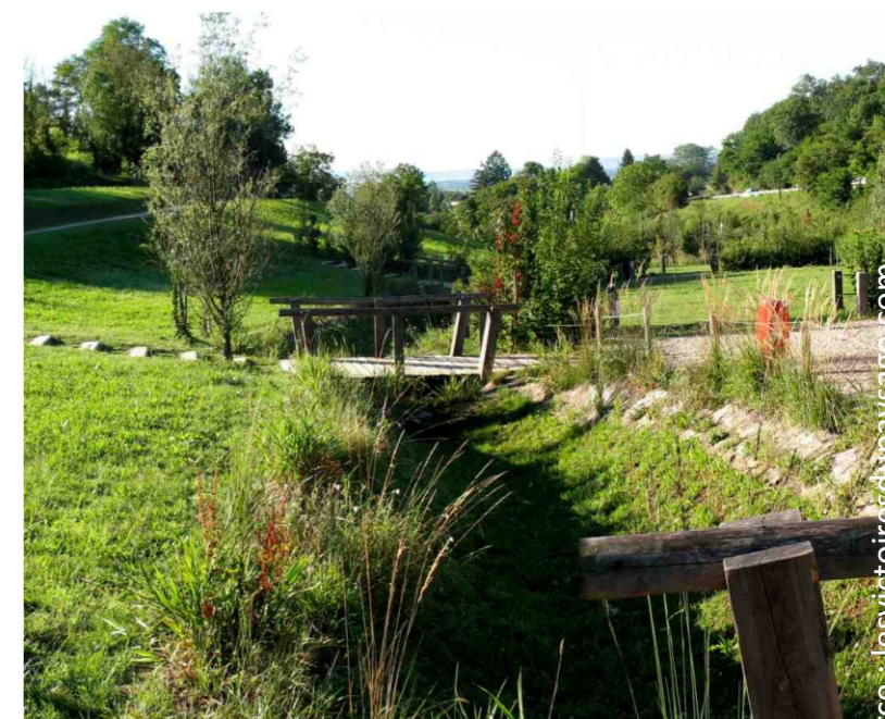
Exemple de noue Le vallon à Pérouges (France)
